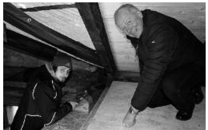
Bürgermeister Johannes Ecke begutachtet zusammen mit Martin Breitfeld den neuen Holzboden
