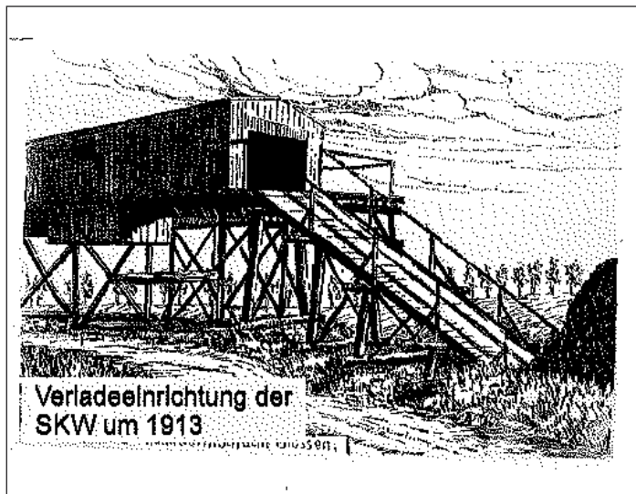
Schrägaufzug und Verladung der Firma SKW Kemmlitz (Federzeichnung E.Würzner)
