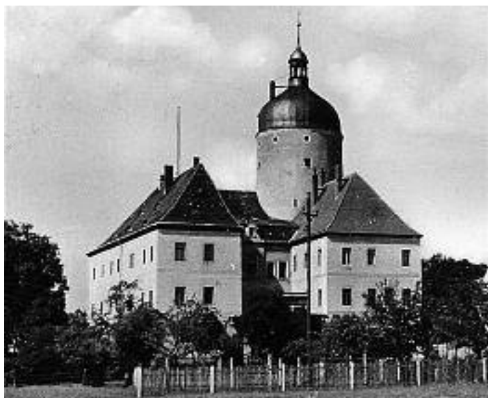
Schloss Ruhethal. Im Erdgeschoss des linken Flügels befand sich die Burgkapelle.
