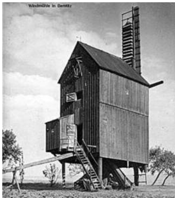
Die beschädigte Bernitzter Windmühle im Herbst 1939
