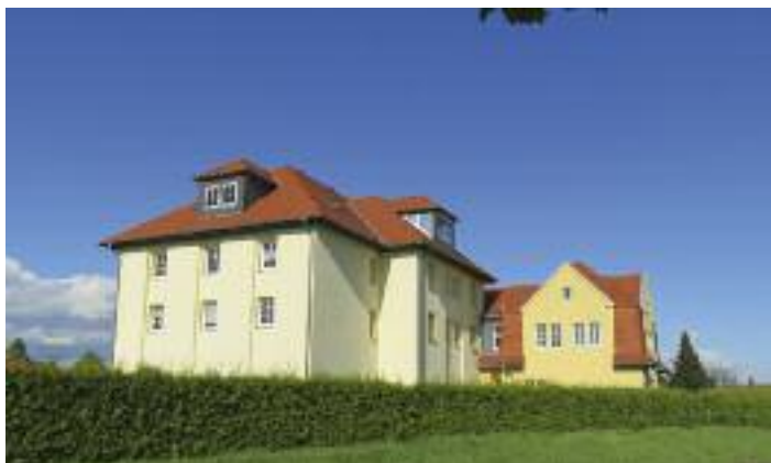
ehem. Schaltwerk Schweta, heute Mehrfamilien-Wohnhaus
