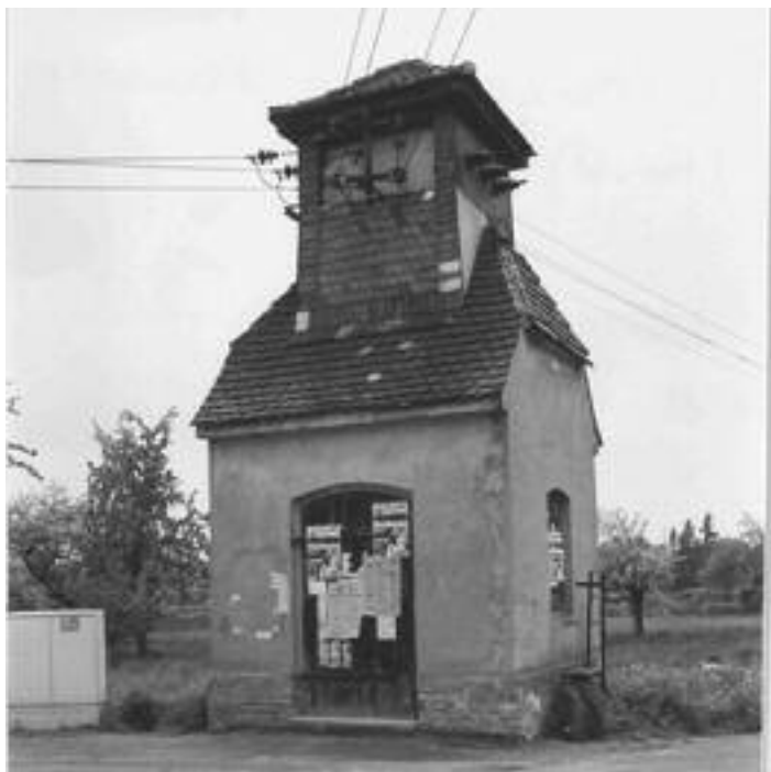
Transformatorstation, fast alle im gleichen Baustil
