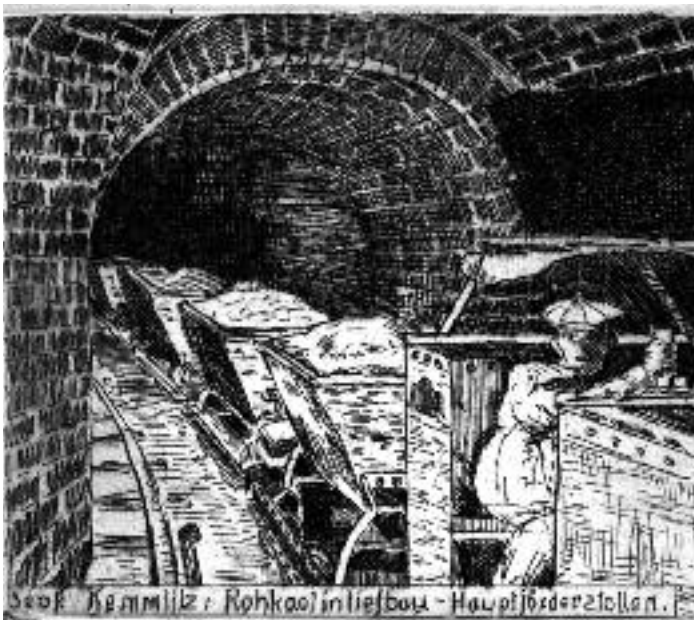
Abb. 3 Alter Förderstollen aus dem Tiefbau
