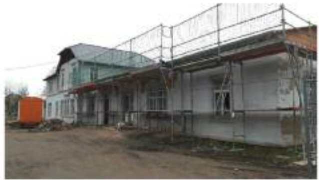
Besuch der Baustelle im März 2018
