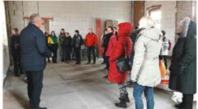
Besuch der Baustelle im April 2018
