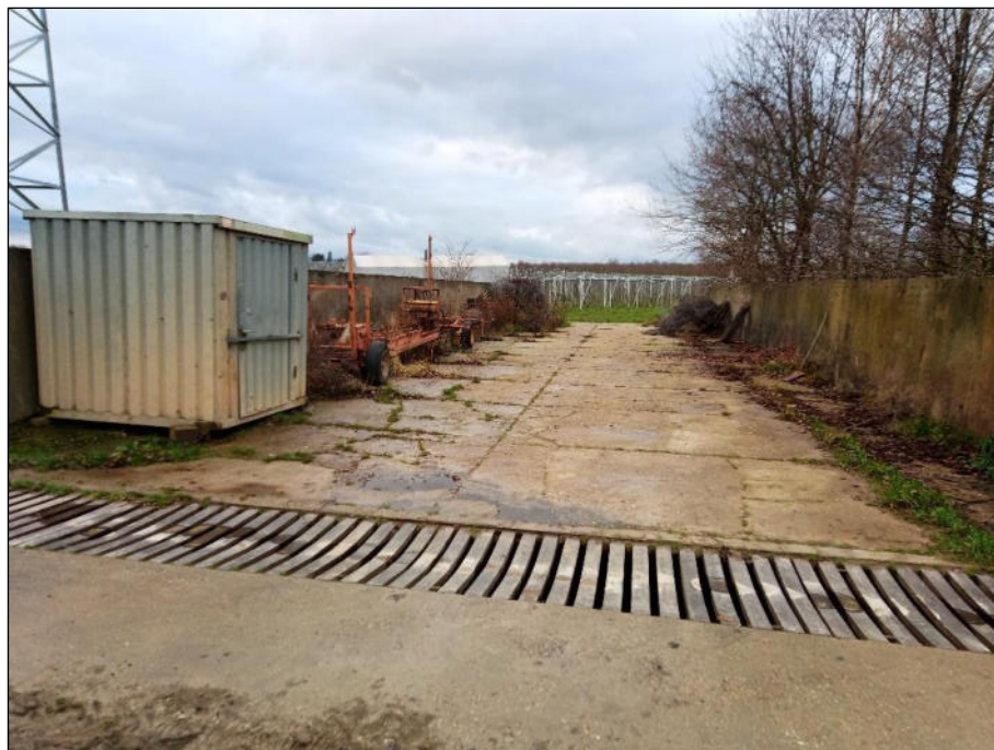
Bild 1: Blick über das Silo in westlicher Richtung (Januar 2023).
